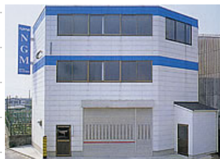
倉庫・乾燥室
